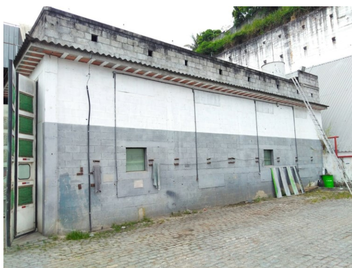
Figura 9 - Cabine de pintura – vista lateral.
