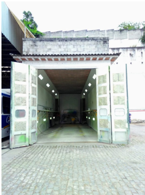
Figura 8 - Cabine de pintura - vista frontal.
