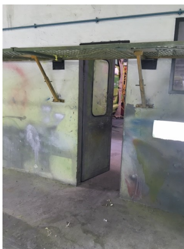
Fig.14 - Porta de entrada sem mola de fechamento
